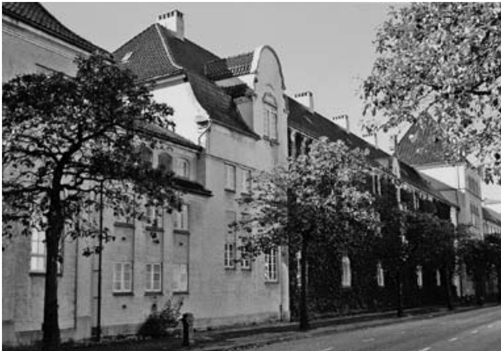
Fra 1880 til 1920-årene ble det reist en rekke store og imponerende folkeskolebygninger i Bergen sentrum. Etter 1945 ble det ledig kapasitet i flere av bygningene, som da kunne tas i bruk til andre formål. En av disse var Nygård skole, der lærerutdanningen i Bergen holdt til fra 1957 til 1965.
