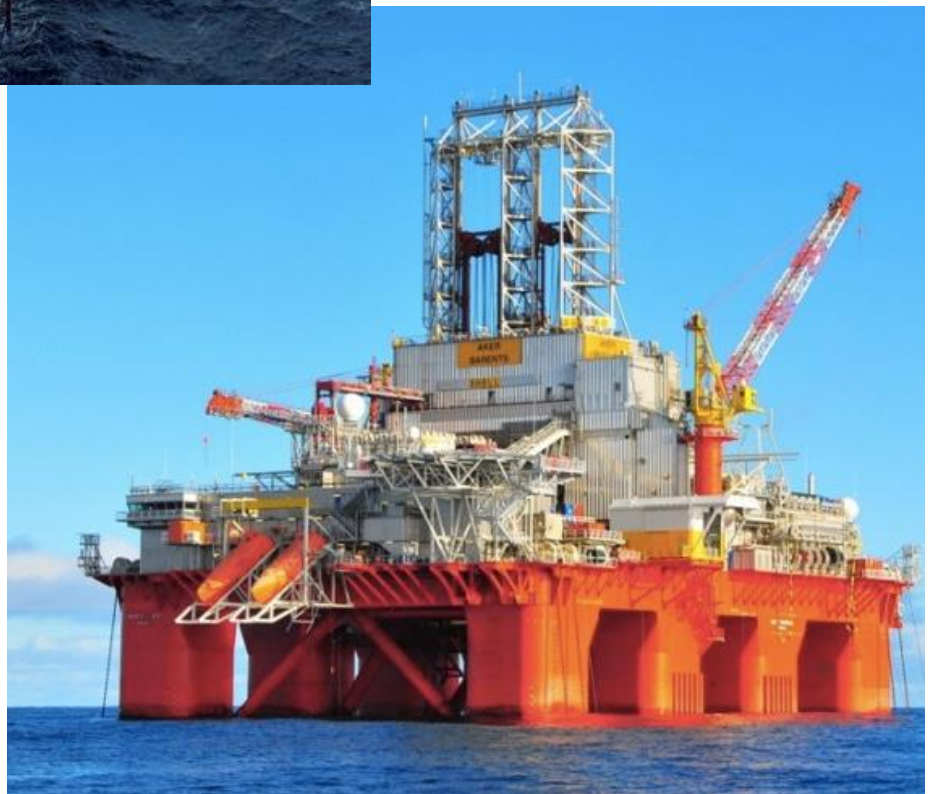
Figur 2 Halvt nedsenkbar boreinnretning Transocean Barents
