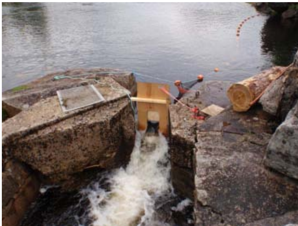
Figur 5. Åpning i laksetrappa og sperrenot på tvers av kanalinnløpet i fase 3. Foto: Å. Johansen.
