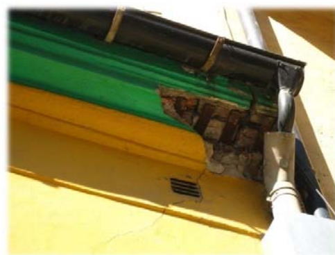
Fig 9 Trekning/ utsmykning gesims. Flere steiner fra trekning har falt ned. (Multiconsult AS)
