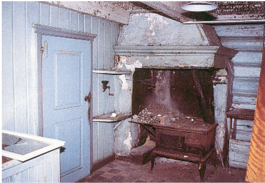
Gamle gruer kan være malt med kalk, limfarge og linoljemaling. Ta kontakt med kulturminneforvaltningen i fylkeskommunen hvis du er i tvil om hvilken malingstype som skal brukes, dersom grua trenger maling. Bruk aldri vannbaserte plastmalinger!
