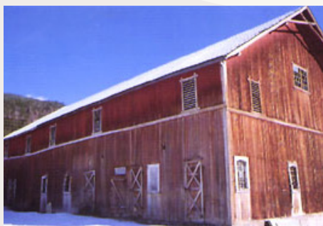
Denne låvebygningen fra Hallingdal er trolig ikke blitt malt på 60 år, og komposisjonsmalingen er delvis vasket av. Når malingen er så sterkt nedbrutt, må overflaten stålborstes godt for nedbrutte fibre før det males på nytt. Foto: Lars Hauglid.
